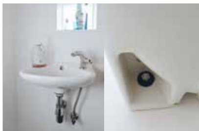
Fixation d'un lavabo avec fixation Hema, filet et écrou
