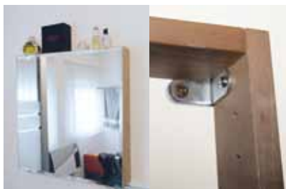
Fixation d'un meuble de salle de bain, cheville normale
