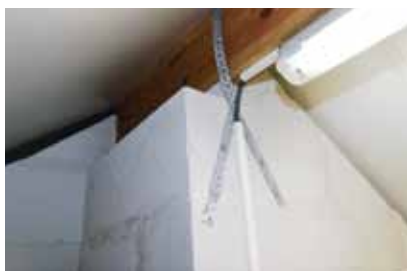
Fixation d'une boucle de charpente avec des clous Hema tête plate
