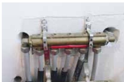
Fixation d'un distributeur d'eau sanitaire avec cheville nylon haute adhérence
