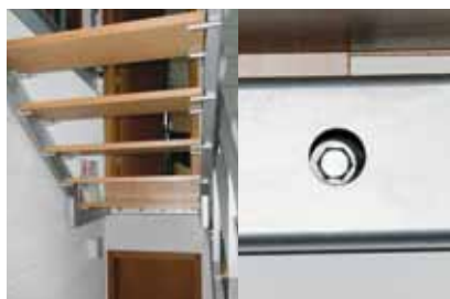
Fixation d'un escalier avec 4 fixations chevilles nylon haute adhérence
